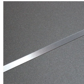
Edelstahl-Streifen (Breite ca. 8 mm) flächenbündig
